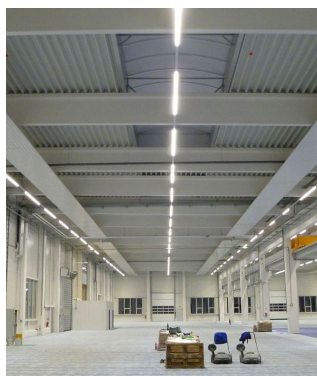
Umrüstung Lagerhalle in Deutschland 60W, 60°,6000K, 500lx auf Boden
